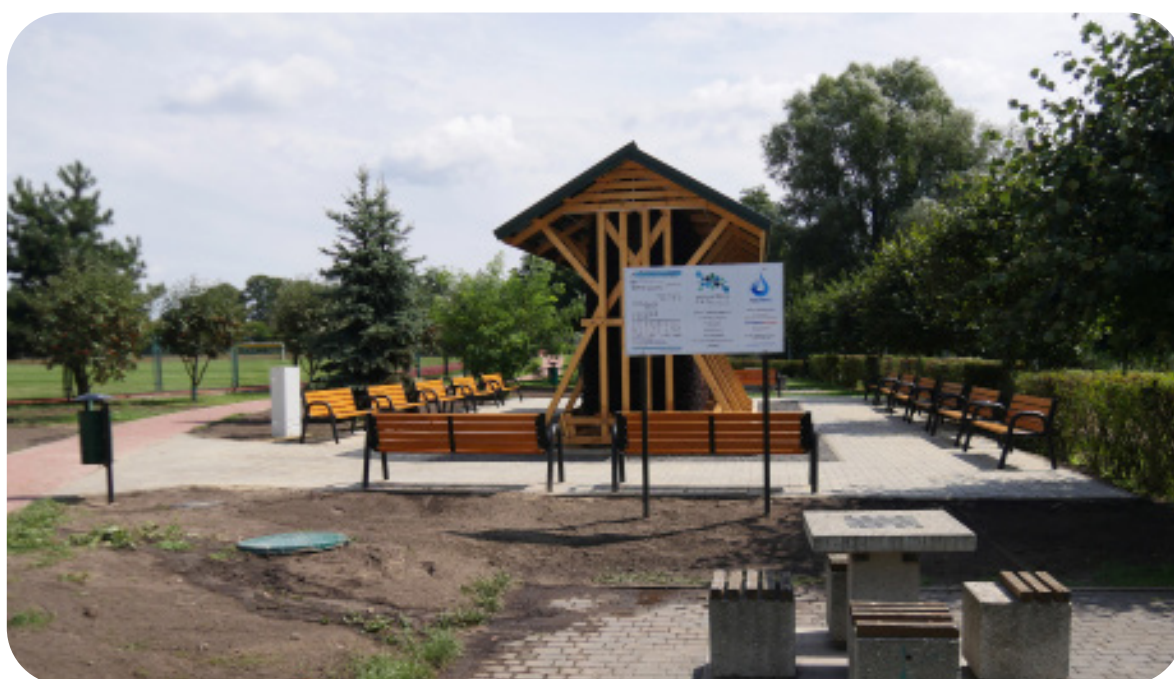
Szczerców, budowa tężni
