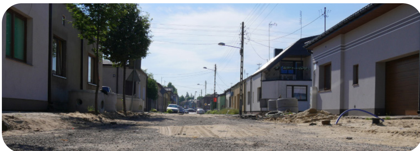
Szczerców, remont ul. Żeromskiego
